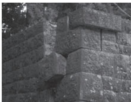
错位的石方维持着原样。
